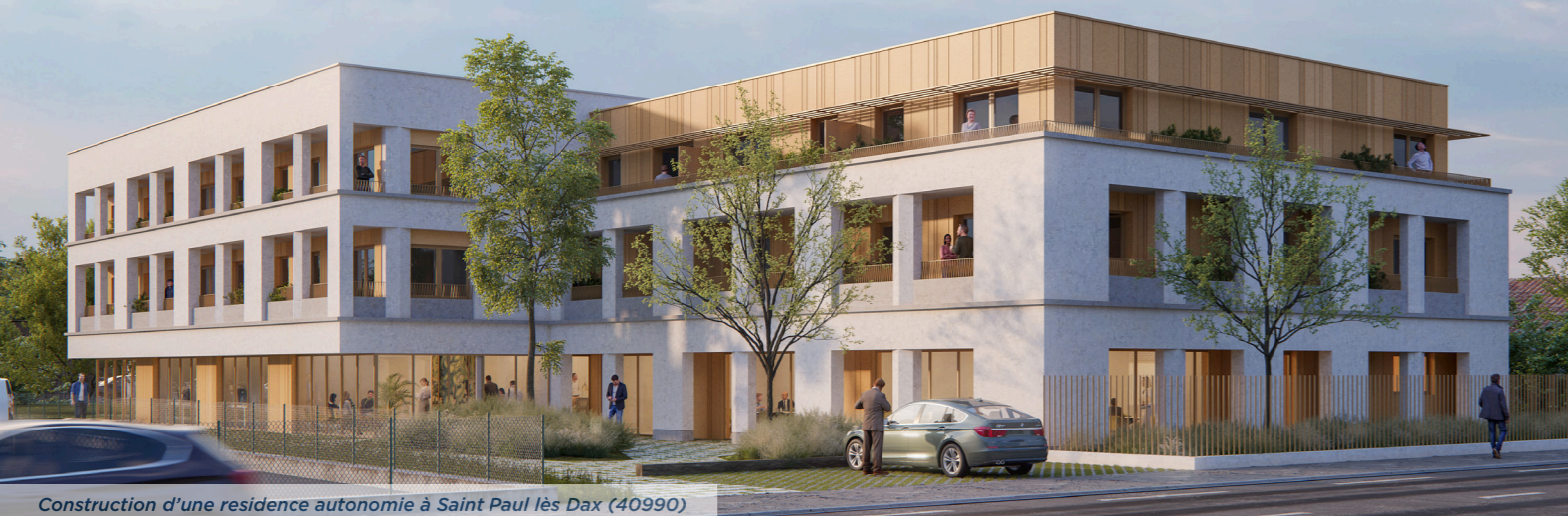
Construction d'une résidence autonomie à Saint Paul lès Dax (40990)
